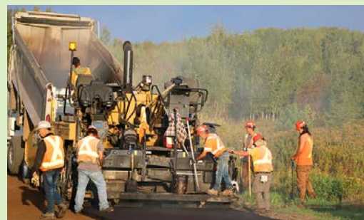
Figure 3. FPIinnovations : Essais d'asphalte modifiée à la lignine sur des segments de route
